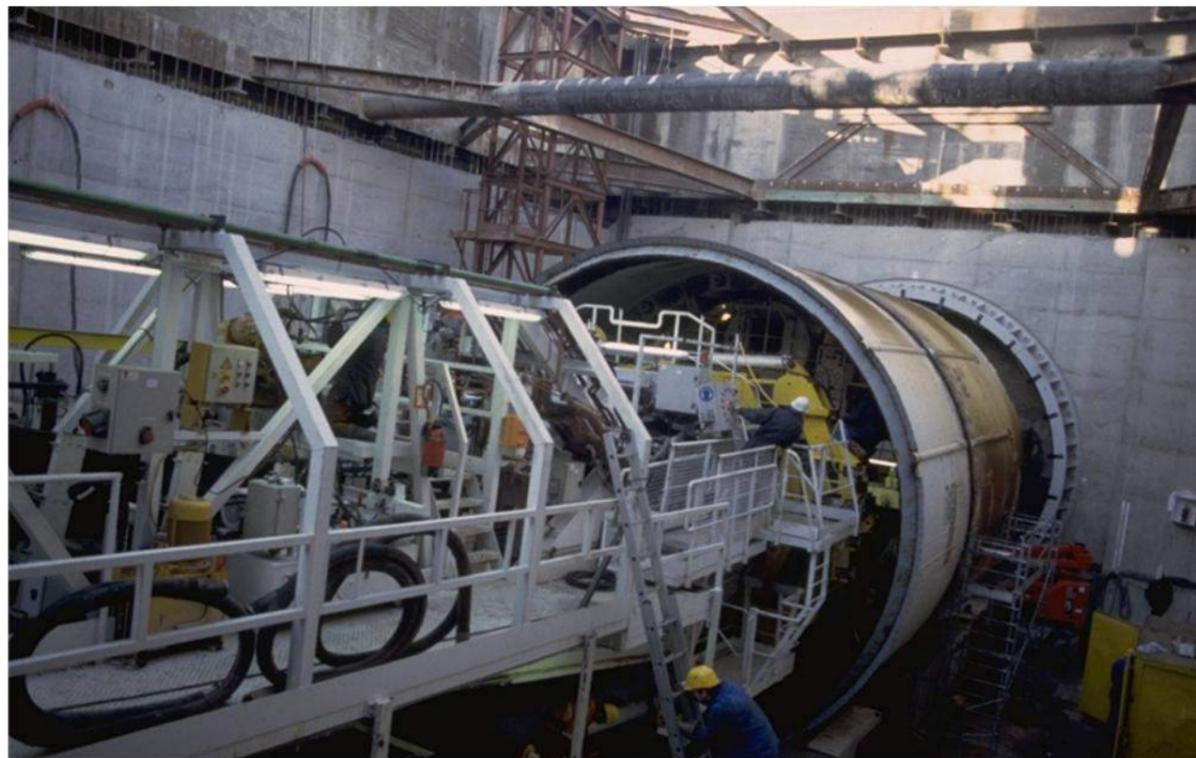
Figure 41 : Montage du bouclier en fond de puits – RATP
